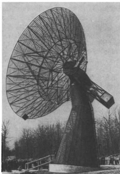
Рис. 37. Радиотелескоп с решетчатым зеркалом.
