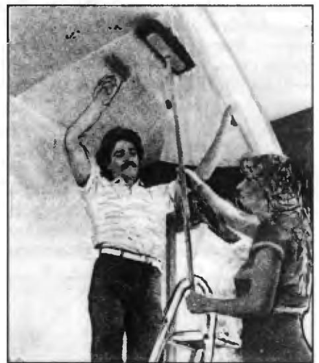
Рис. 10. Оклейку потолка лучше выполнять с помощником
