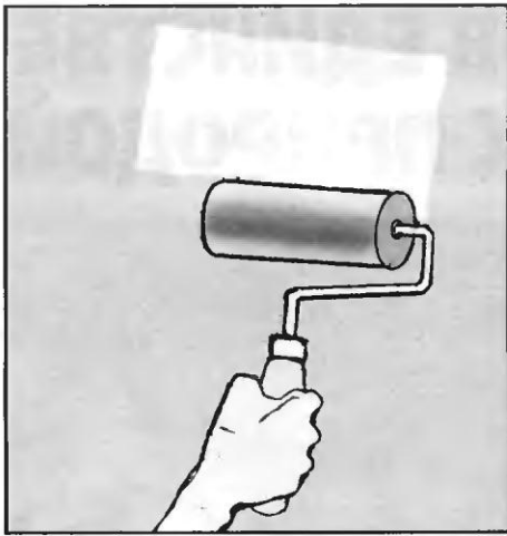
Рис. 15. Для наклейки обоев на стены предварительно наносится слой клея. Это удобно делать с помощью валика
