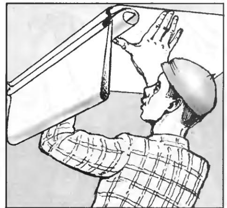
Рис. 9. Полотно с клеем собирается «гармошкой» со свисающим концом и на стержне переносится к месту приклейки
