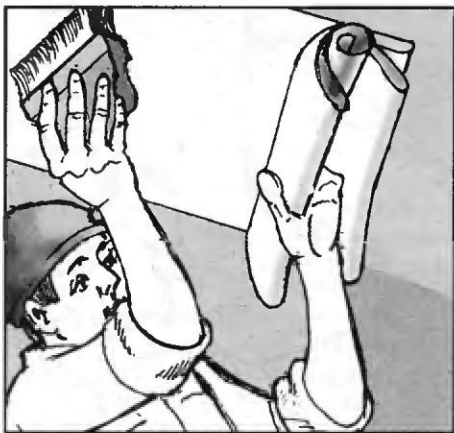
Рис. 11. Прижимание полотна ведётся от середины к краям
