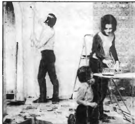
Рис. 8. Намазывать обои клеем удобнее на столе
