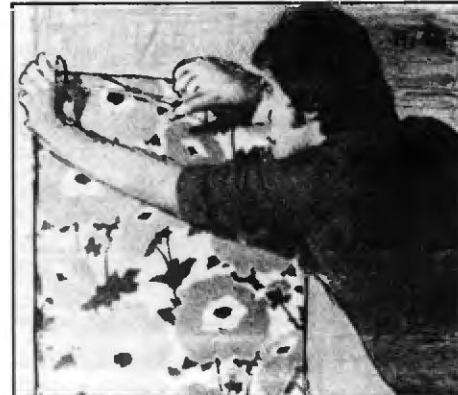
Рис. 18. Приклеивание полотна начинается с верхнего края
