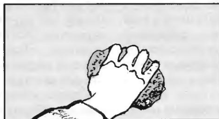
Рис. 3. Зашпаклёванные места стен шлифуются шкуркой или проволочной пуганицей
