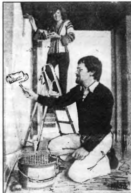
Рис. 4. Поражённые плесенью участки стен обрабатываются олифой, затем наносится слой обойного клея
