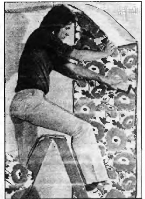
Рис. 19. Разравнивают полотнище на стене щёткой от середины к краям
