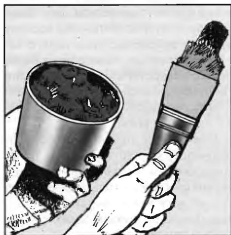
Рис. 2. Дефектные места стен шпаклюются, заполняются штукатурным раствором
