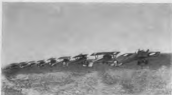
Русский истребительный авиационный отряд в 1916 году. На крайнем правом самолете виден синхронный пулемет, на третьем и пятом справа — пулеметы, установленные для стрель- бы вверх винта.
