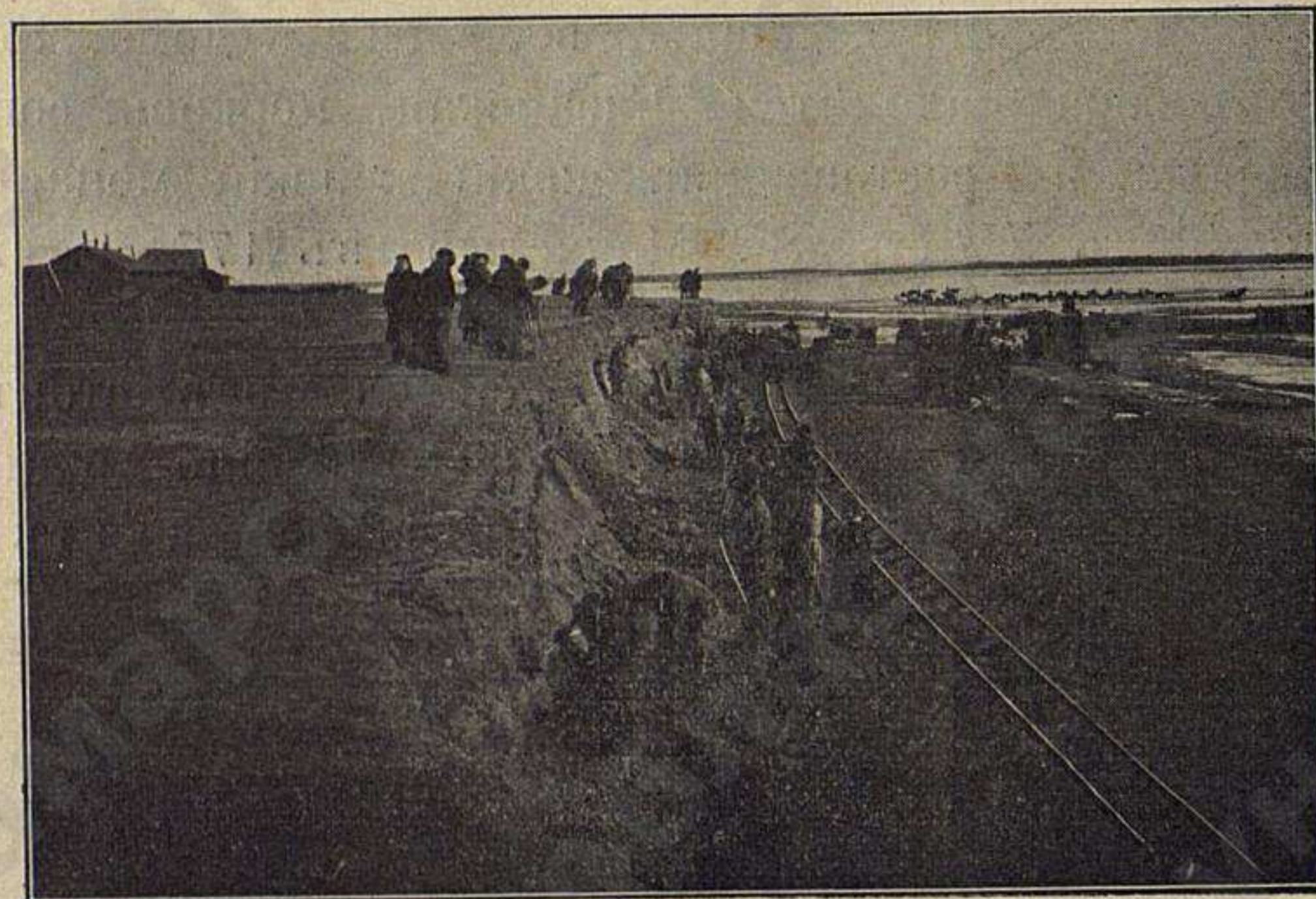
Работы по углубленію русла Волги.
